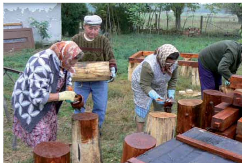
R5-4 | Tanösvény építésének előkészületei
